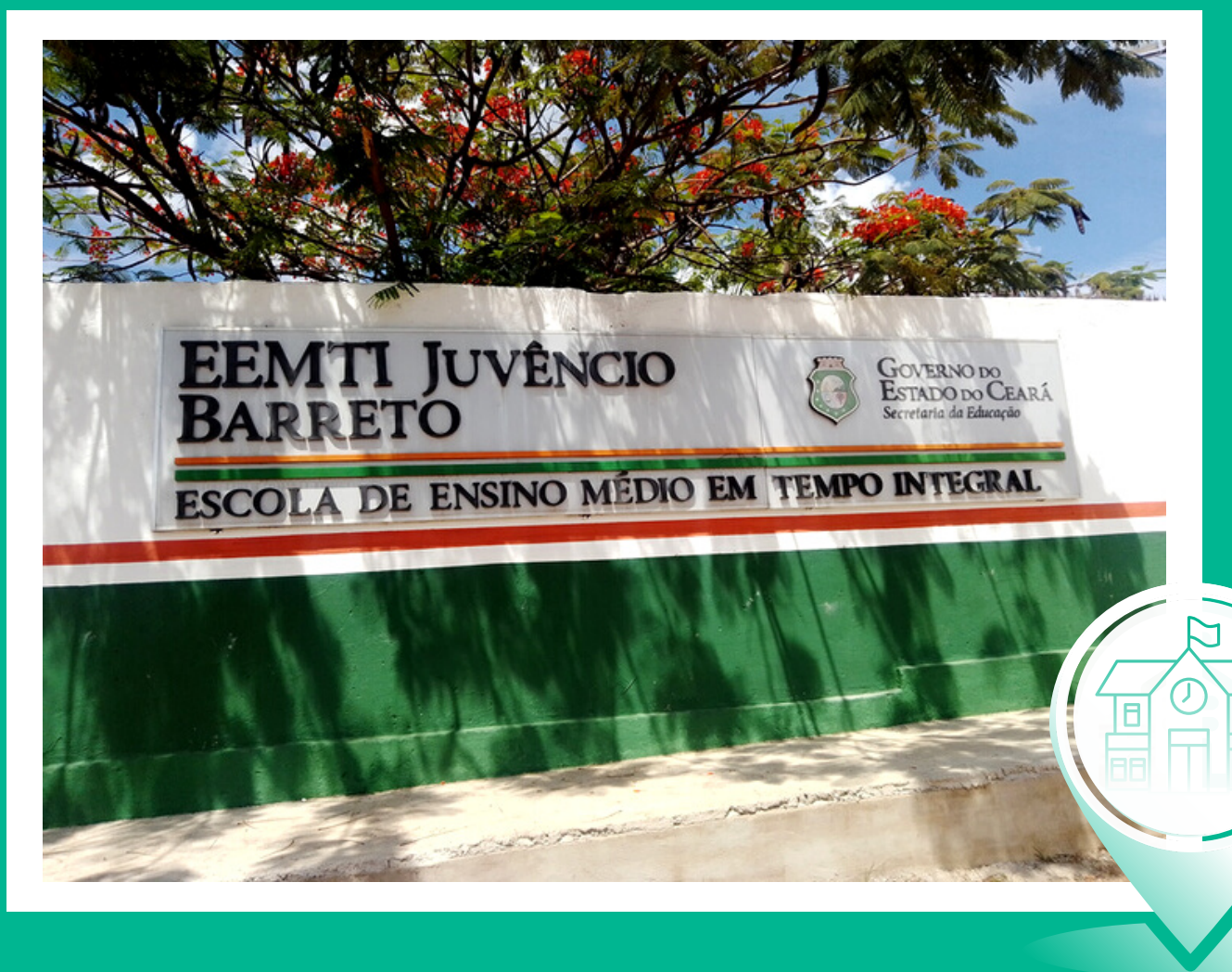
FIGURA 13 E 14 - EMTI JUVÊNIO BARRETO NO BAIRRO GISÉLIA PINHEIRO (EM REFORMA)
